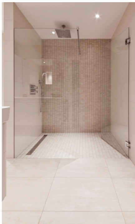
Figur 2: Fliser med ensidig fall, et nedsenket dusjområde avskjernet med glass er en effektiv måte å innfri fallgravene, krav til tilgjengelighet for rullestolbruker og høydeforskjeller mellom sluk og dør.
