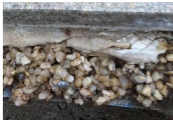
Figur 8: Eksempel på rundkornet dreneringsmørtel med epoksy bindemiddel
