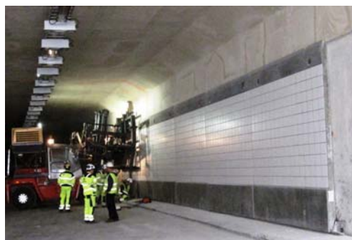
Figur 4 a og 4: Elementene ble heist på plass og festet med mekanisk forankring i topp og bunn. Avstanden til betongen bak er ca 25 mm.
