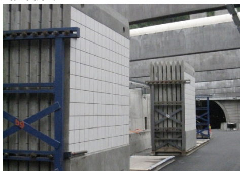
Figur 4 a og 4: Elementene ble heist på plass og festet med mekanisk forankring i topp og bunn. Avstanden til betongen bak er ca 25 mm.
