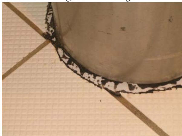
Figur 3: Typisk fuge med fargeendring grunnet mikroorganismer.
