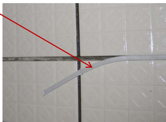
Figur 7: Elastisk fugemasser kun i flissjiktet har lett for å løsne i klorholdige omgivelser.
