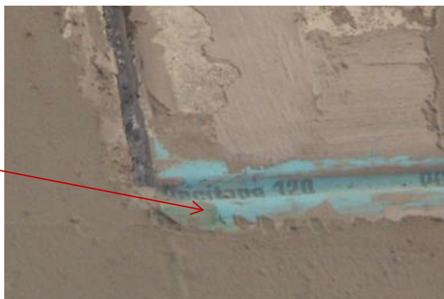
Figur 4: Fugebåndene kan bidra til ettergivende underlag ut mot fugekanten.
