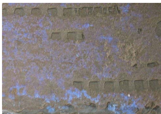
Bilde 5: Plasttilsetninger kan redispersere fra lim og blir synlig som en seig væske når flisen fjernes.
