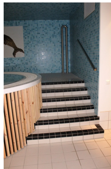
Figur 3: God kontrast på trappefront både på inn – og opptrinn gjør trinnene godt synlige.
