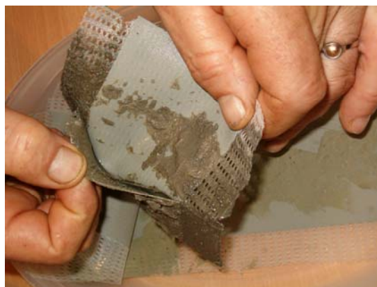
Bilde 3: Fugebåndet må være av en kvalitet som tåler påkjenningen. Svikter fuge har dette store følgeskader.
