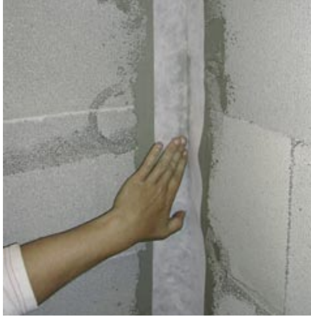
Figur 3: Forsterkning av hjørner med tettebånd.
