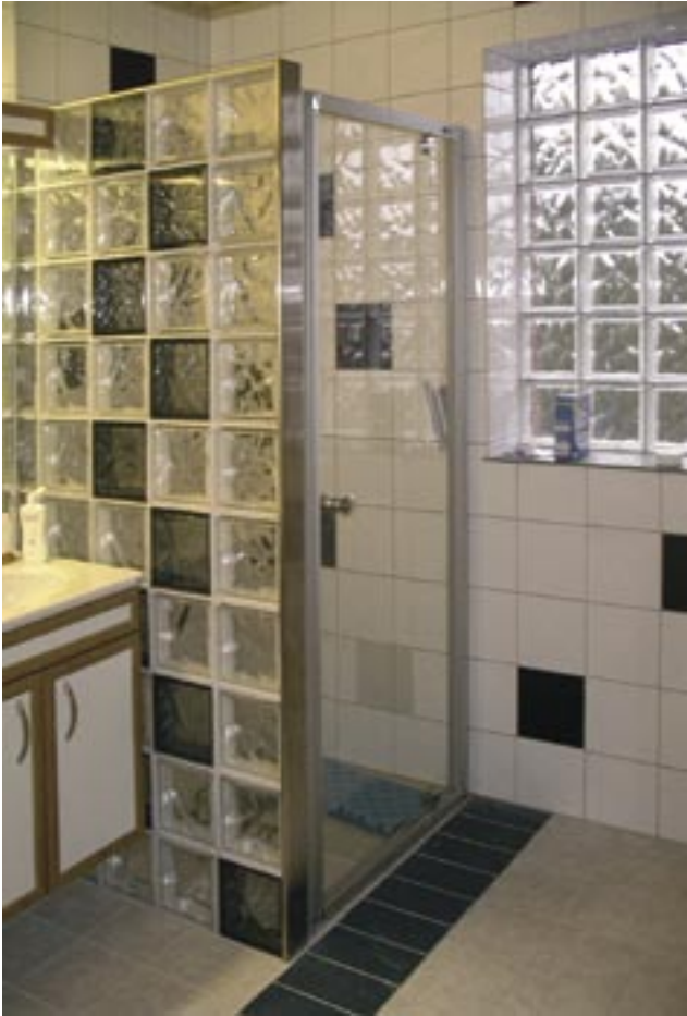
Glassbyggestein brukt både i yttervegg og som dusjskillevegg
