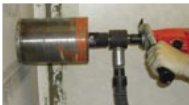
Figur 2: Boring av hull for veggbokse
