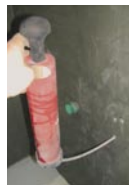
Figur 12: Hullet blåses rent for støv før tokomponent masse presses inn i forborede hull
