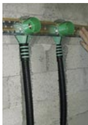
Figur 5: Veggbokser med tilbehør plasseres i riktig høyde
