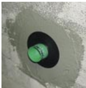
Figur 7: Bruk av gummipakning rundt veggboks
