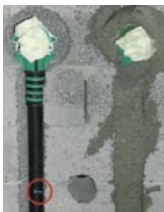
Figur 6: I de slissede sporene holdes rørene på plass vha. spesielle klammere, eller skråspikring (se rød sirkel)
