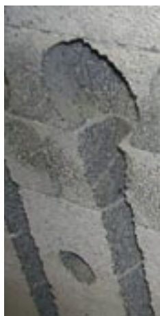
Figur 3 Spor til rør slisses i min. 40 mm dybde og 35 mm bredde eller slik at ferdig innpusset rør får en overdekning på ca 10 mm
