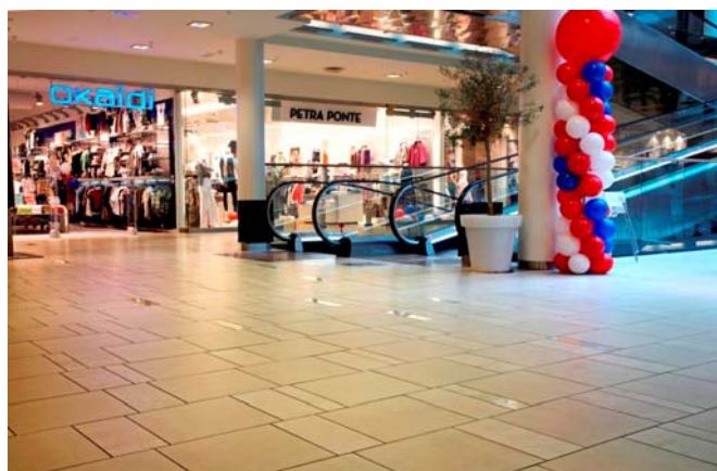
Figur 12a og b: Det er underlaget det kommer an på. Svært sjelden er det problemer med selve fliskvalitetene. Men underlagsprosjektering og fugeplassering er en prosjekteringsoppgave som må ha fokus.
