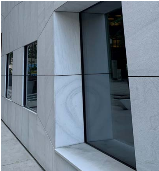
Figur 2 (til venstre) : Dyptliggende vindussmyg tilpasset fasadens fugemønster samt sålbenk med dryppkant.
