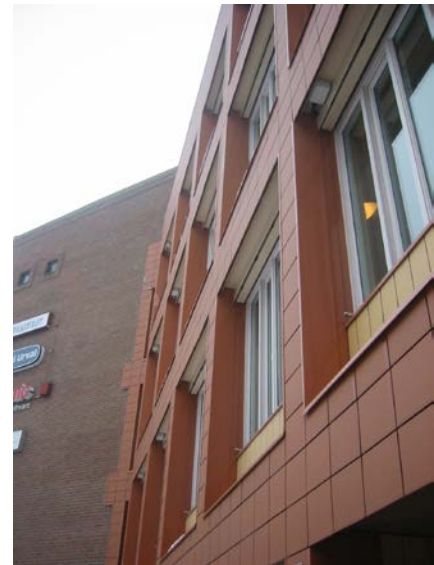
Figur 2 (til venstre) : Dyptliggende vindussmyg tilpasset fasadens fugemønster samt sålbenk med dryppkant.
