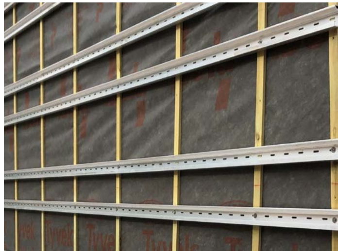
Figur 5a og b: Eksempel på ekspansjonsbolter ( Venstre) og opphengskinner ( Høyre)
