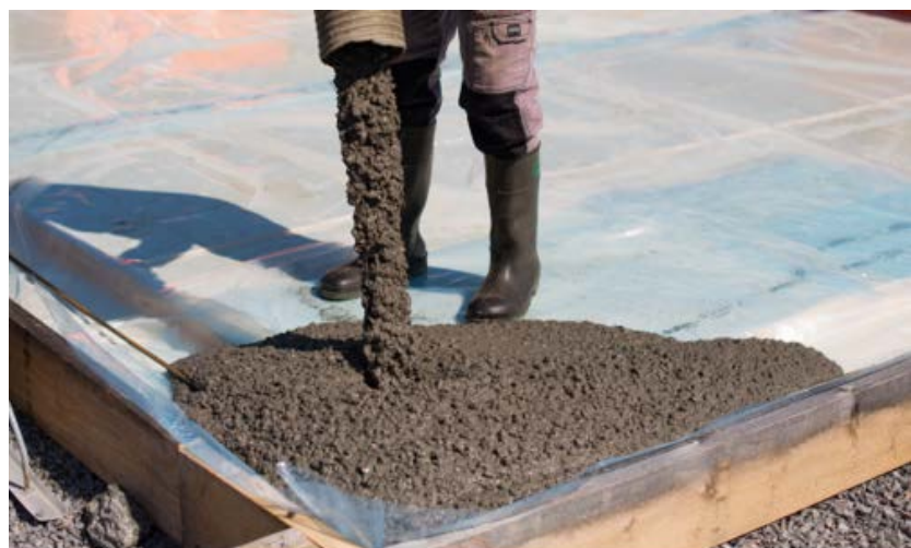
Figur 3: Riktig proporsjonering og god logistikk på byggeplassen kan bidra til at store flater kan legges uten støpeskjøter og uten feltinndeling.
