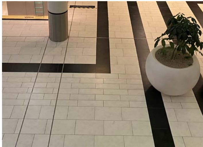
Figur 1: Forutsatt stabilt underlag kan et flislagt gulv holde seg fint i hele byggets levetid.
