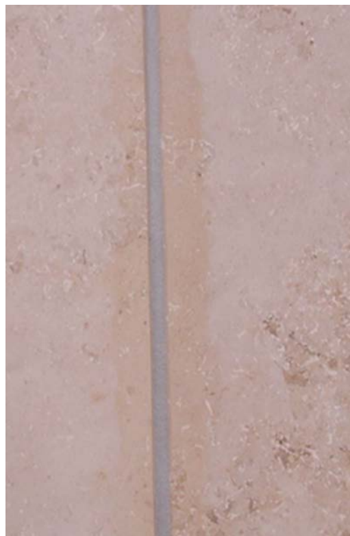
Figur C a og b: Eddikbasert silikon kan gi varig avsmetting i steinen både på skifrige og kalkholdige bergarter.
