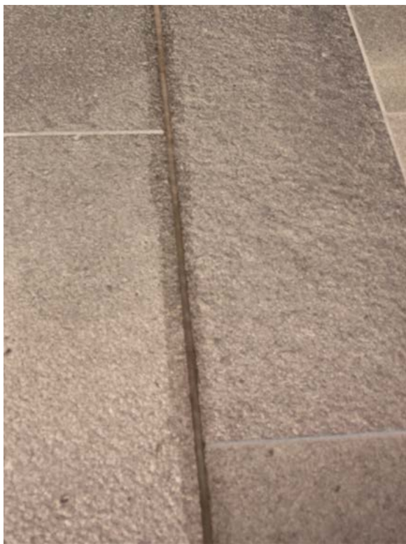
Figur C a og b: Eddikbasert silikon kan gi varig avsmetting i steinen både på skifrige og kalkholdige bergarter.
