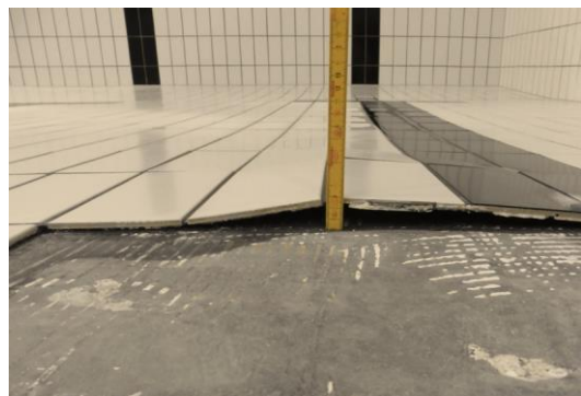
Figur 3: En betongkonstruksjon fortsetter å trekke seg sammen i flere år etter utstøping. (Illustrasjon: Sopro)
